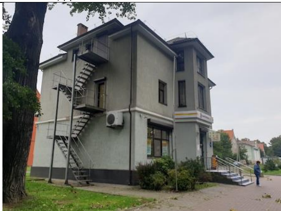
Фото 2. Внешнее состояние объекта
