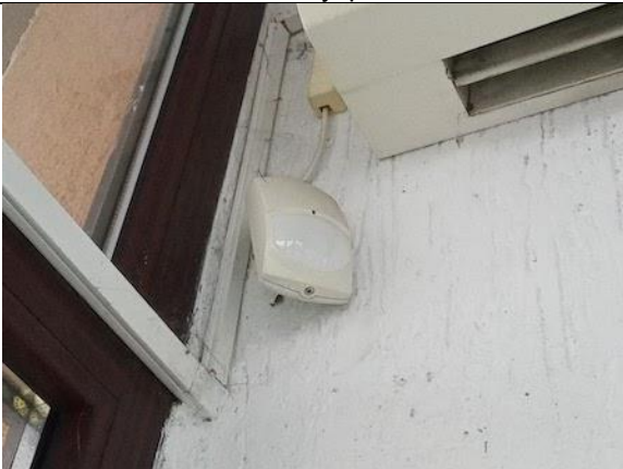
Фото 53. Состояние внутренних помещений.
