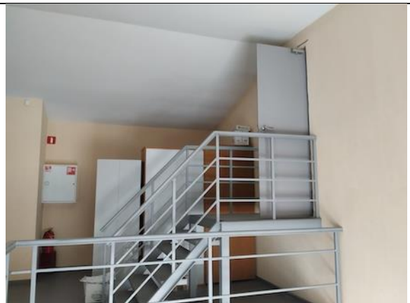
Фото 62. Этаж 5. Внутреннее помещение объект.
