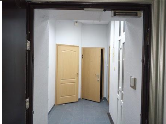
Фото 67. Состояние внутренних помещений.
