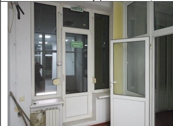
Фото 61. Состояние внутренних помещений.
