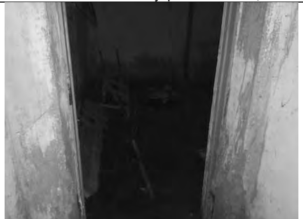
Фото 48. Состояние внутренних помещений.
