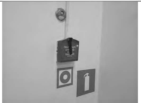
Фото 18. Состояние внутренних помещений.
