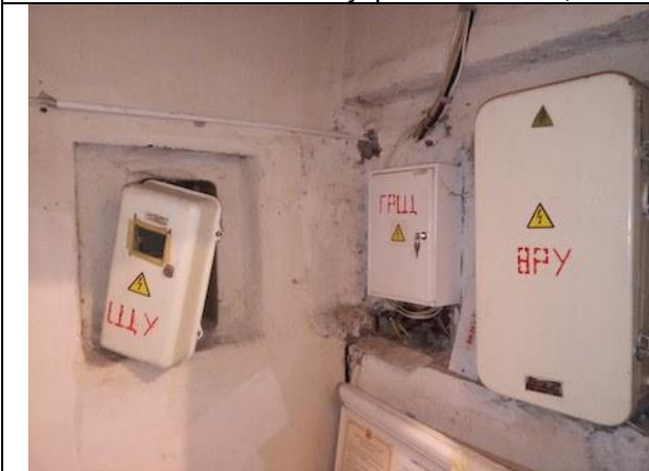
Фото 23. Состояние внутренних помещений.
