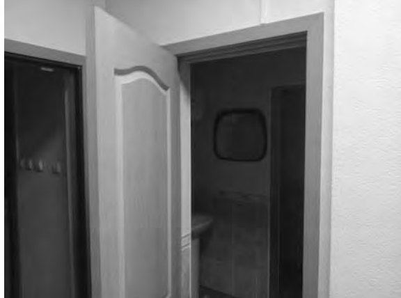
Фото 75. Состояние внутренних помещений.
