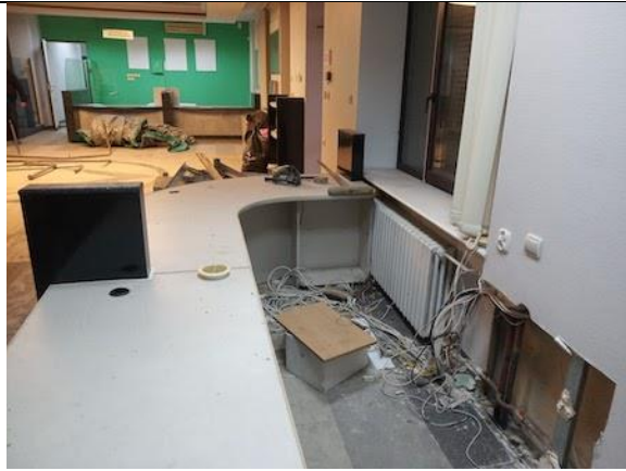
Фото 65. Состояние внутренних помещений.
