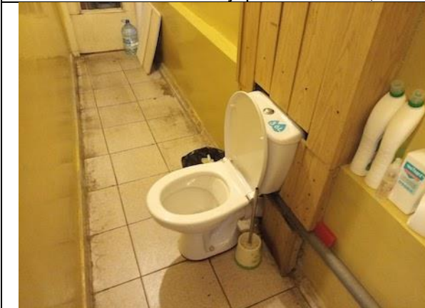
Фото 35. Состояние внутренних помещений.
