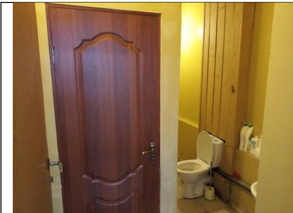
Фото 33. Состояние внутренних помещений.
