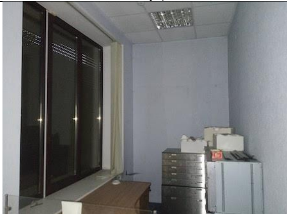
Фото 69. Состояние внутренних помещений.
