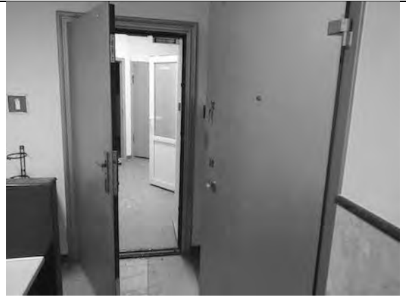
Фото 66. Состояние внутренних помещений.
