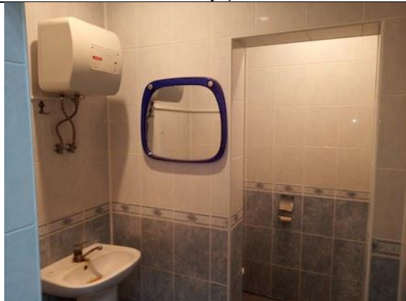
Фото 77. Состояние внутренних помещений.
