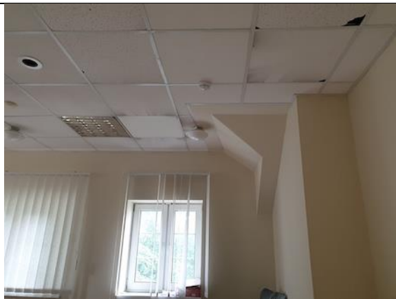
Фото 37. Этаж 3. Внутренние помещения объекта.
