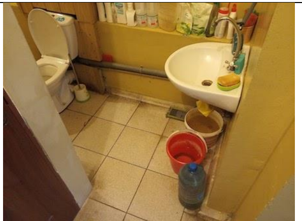
Фото 34. Состояние внутренних помещений.
