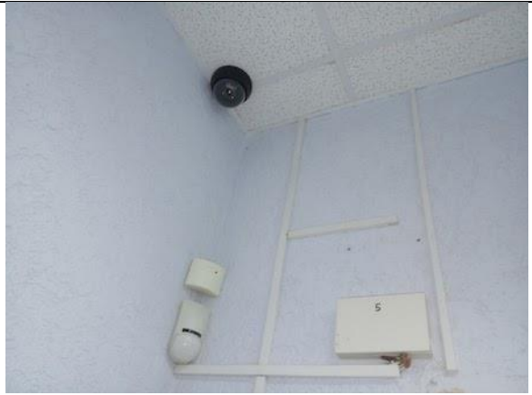
Фото 74. Состояние внутренних помещений.
