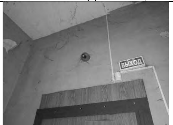
Фото 38. Состояние внутренних помещений.
