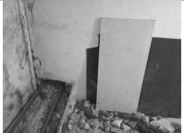
Фото 44. Состояние внутренних помещений.
