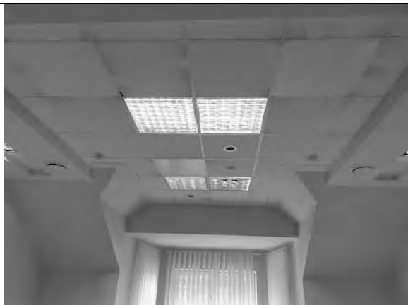
Фото 35. Этаж 3. Внутренние помещения объекта.
