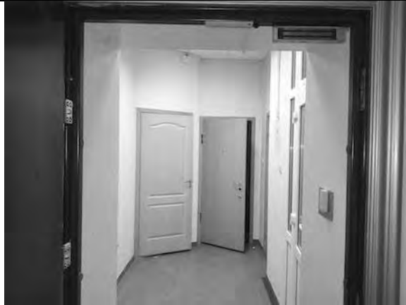
Фото 67. Состояние внутренних помещений.
