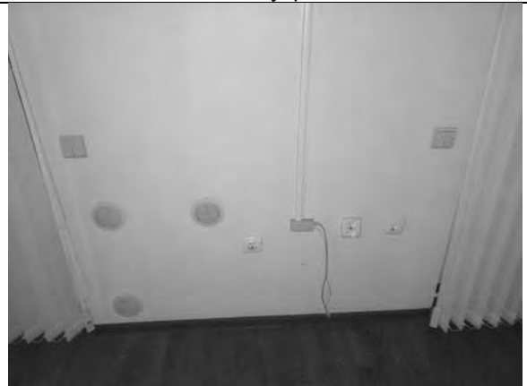
Фото 62. Состояние внутренних помещений.
