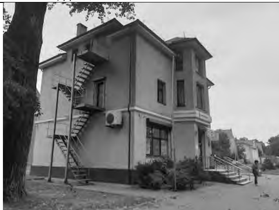
Фото 2. Внешнее состояние объекта
