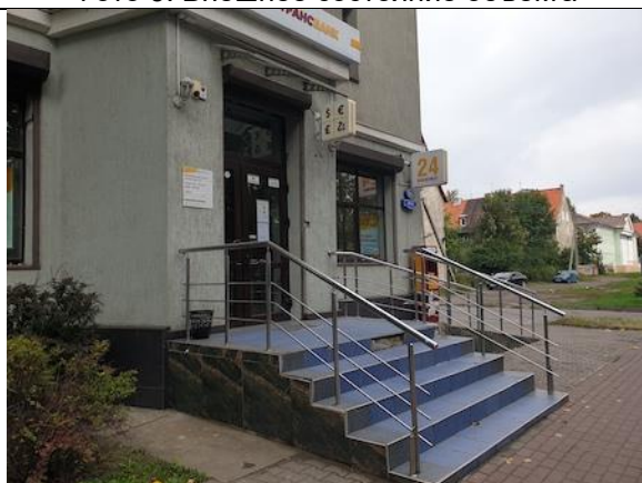
Фото 5. Внешнее состояние объекта
