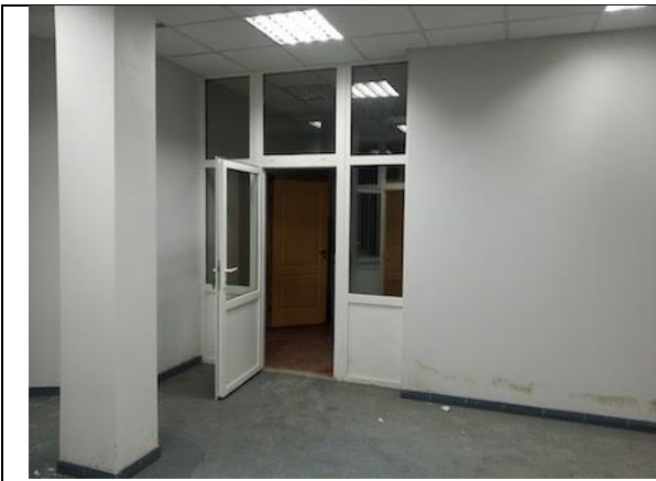
Фото 57. Состояние внутренних помещений.
