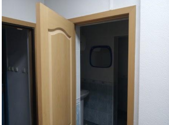
Фото 75. Состояние внутренних помещений.
