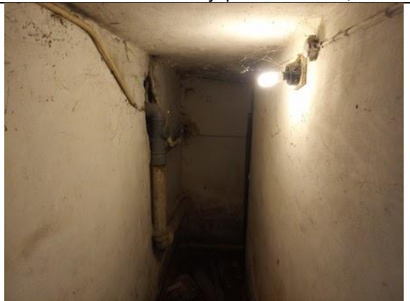
Фото 46. Состояние внутренних помещений.
