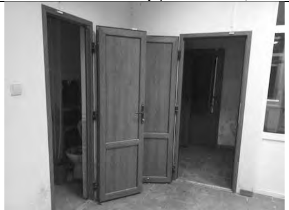
Фото 56. Состояние внутренних помещений.
