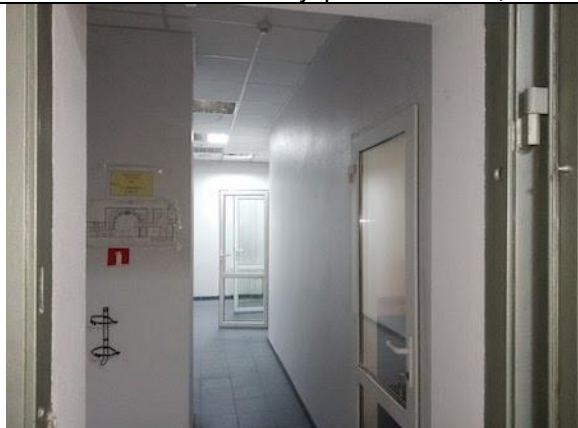
Фото 79. Состояние внутренних помещений.
