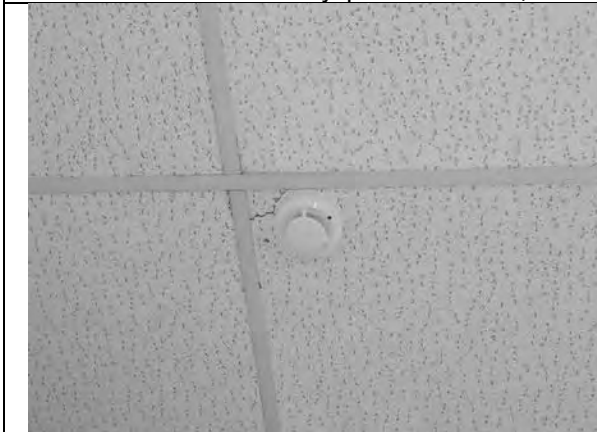
Фото 19. Состояние внутренних помещений.
