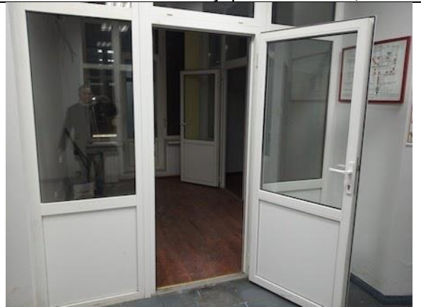
Фото 60. Состояние внутренних помещений.
