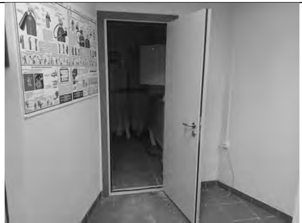
Фото 58. Состояние внутренних помещений.
