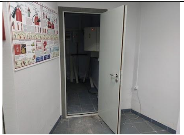
Фото 58. Состояние внутренних помещений.
