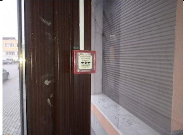
Фото 52. Состояние внутренних помещений.
