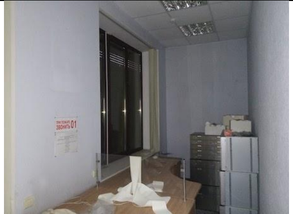
Фото 68. Состояние внутренних помещений.
