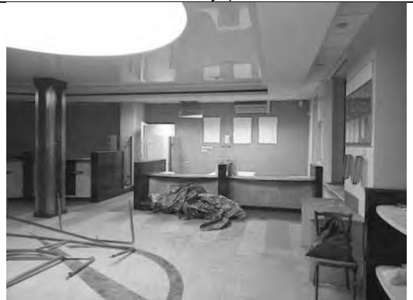
Фото 54. Состояние внутренних помещений.
