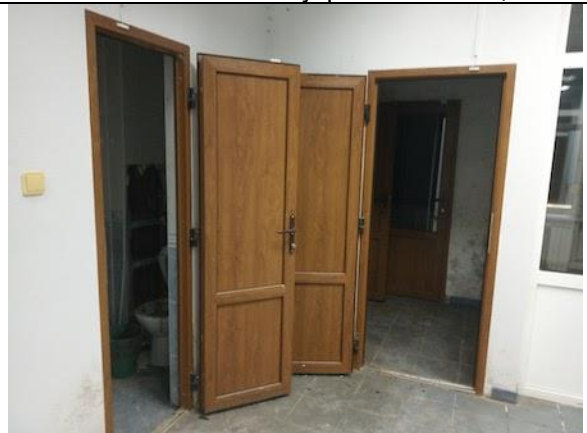
Фото 56. Состояние внутренних помещений.
