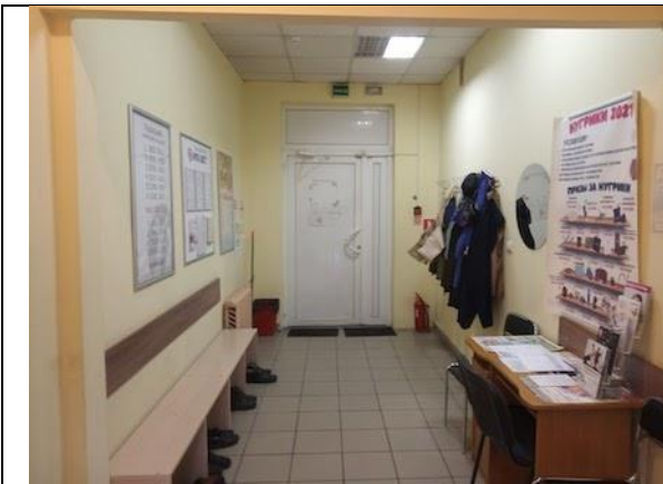
Фото 17. Состояние внутренних помещений.
