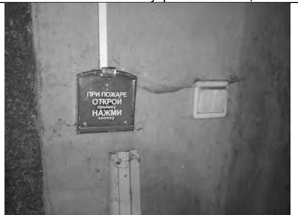
Фото 40. Состояние внутренних помещений.
