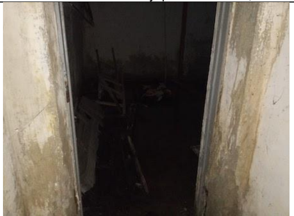
Фото 48. Состояние внутренних помещений.
