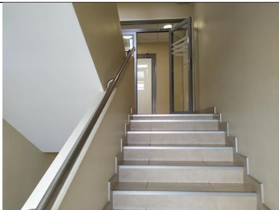
Фото 44. Этаж 3. Внутреннее помещение объекта.
