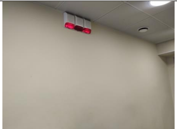
Фото 20. Этаж 1. Внутреннее помещение объекта.
