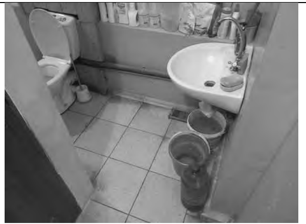
Фото 34. Состояние внутренних помещений.
