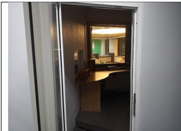
Фото 81. Состояние внутренних помещений.
