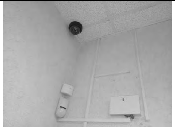
Фото 74. Состояние внутренних помещений.
