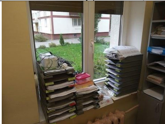
Фото 27. Состояние внутренних помещений.
