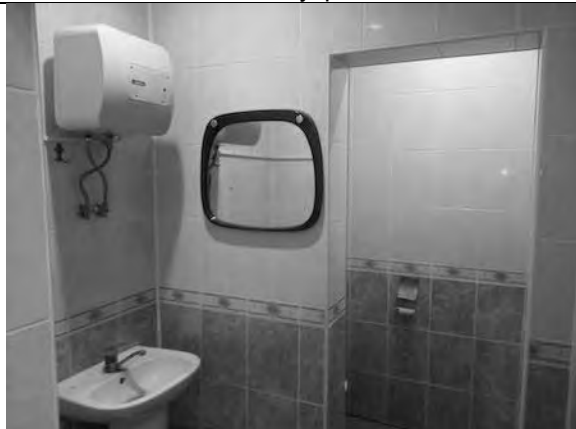
Фото 77. Состояние внутренних помещений.
