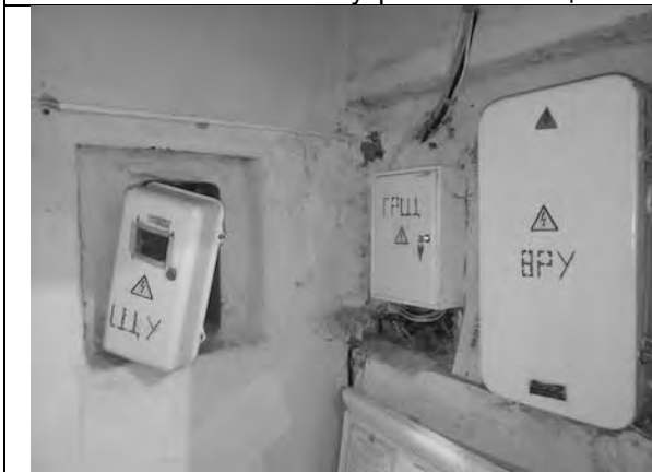
Фото 23. Состояние внутренних помещений.
