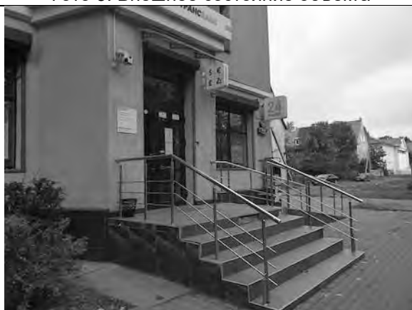
Фото 5. Внешнее состояние объекта
