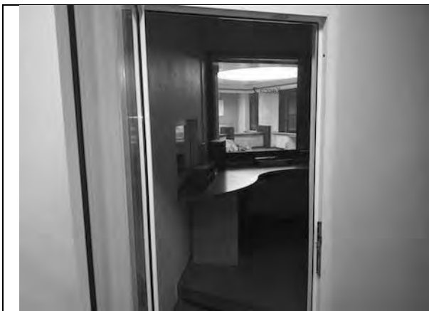
Фото 81. Состояние внутренних помещений.
