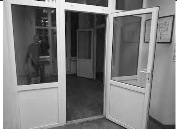
Фото 60. Состояние внутренних помещений.
