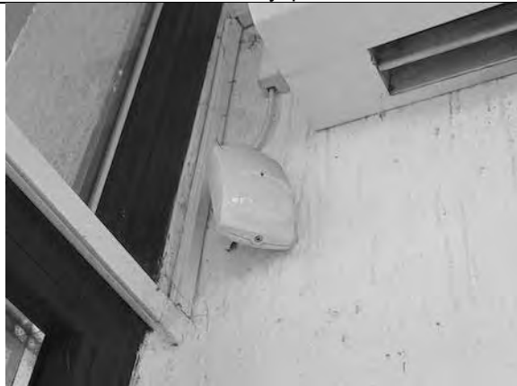
Фото 53. Состояние внутренних помещений.
