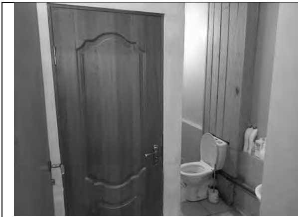
Фото 33. Состояние внутренних помещений.
