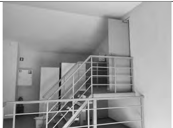
Фото 62. Этаж 5. Внутреннее помещение объект.
