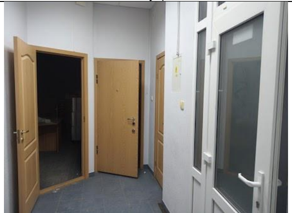
Фото 70. Состояние внутренних помещений.
