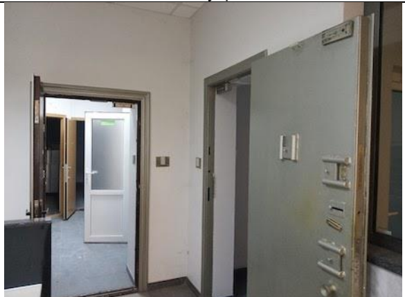
Фото 78. Состояние внутренних помещений.
