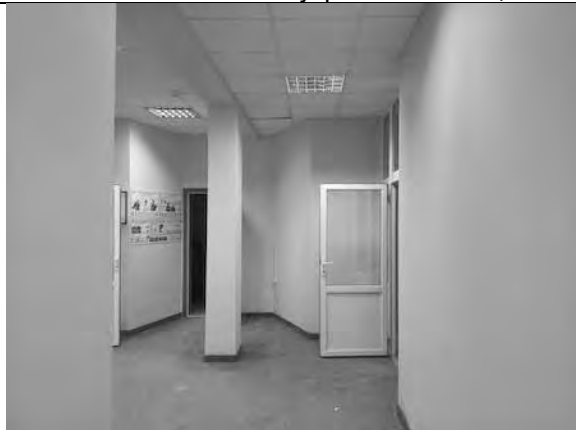
Фото 55. Состояние внутренних помещений.
