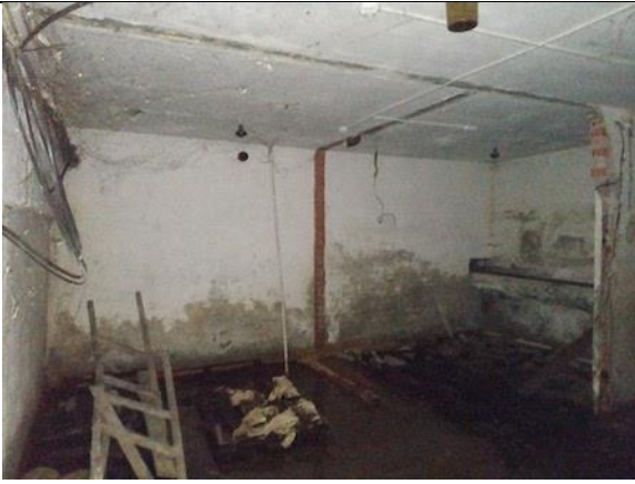
Фото 49. Состояние внутренних помещений.
