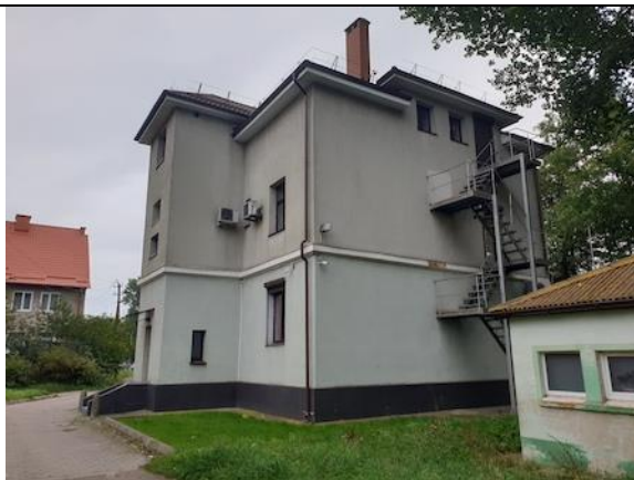
Фото 8. Внешнее состояние объекта
