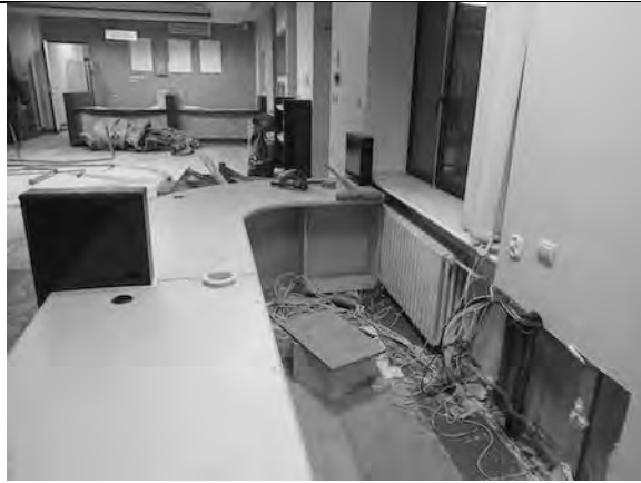
Фото 65. Состояние внутренних помещений.
