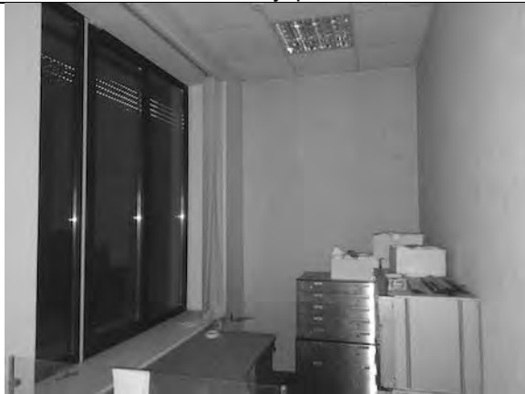
Фото 69. Состояние внутренних помещений.
