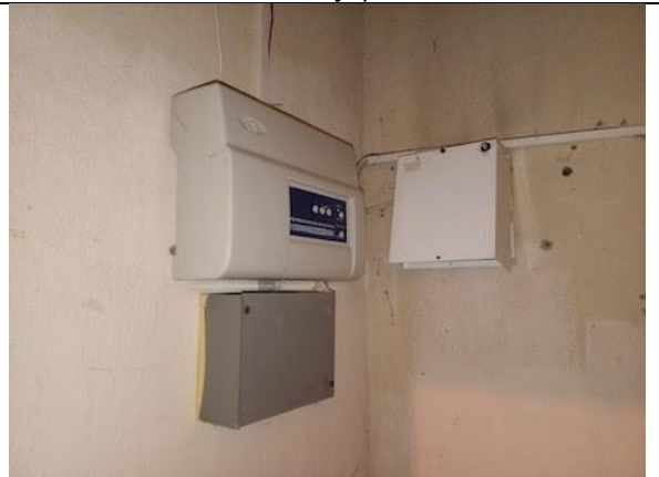
Фото 22. Состояние внутренних помещений.
