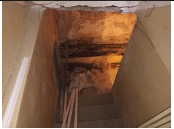
Фото 42. Состояние внутренних помещений.
