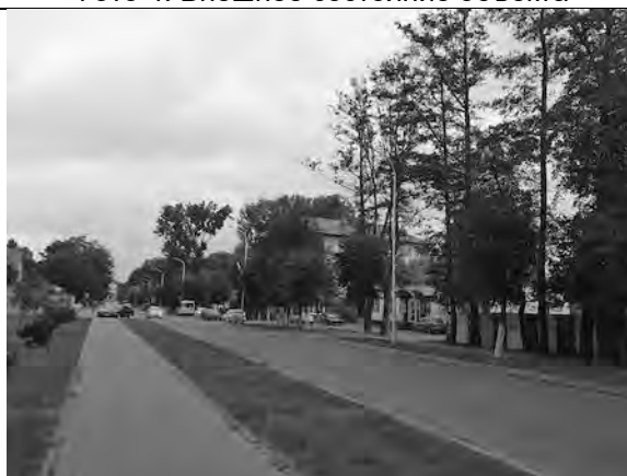
Фото 6. Внешнее состояние объекта
