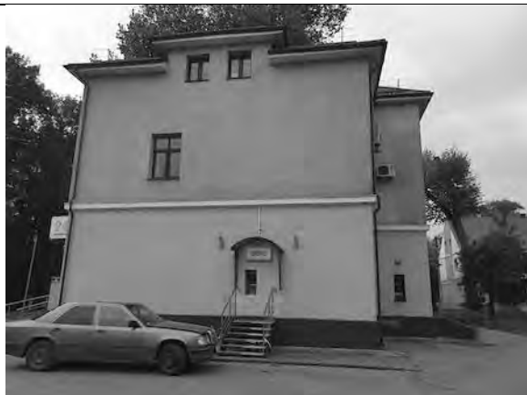
Фото 7. Внешнее состояние объекта
