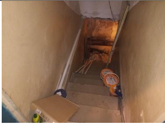
Фото 41. Состояние внутренних помещений.
