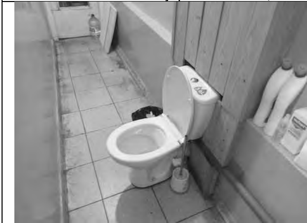
Фото 35. Состояние внутренних помещений.
