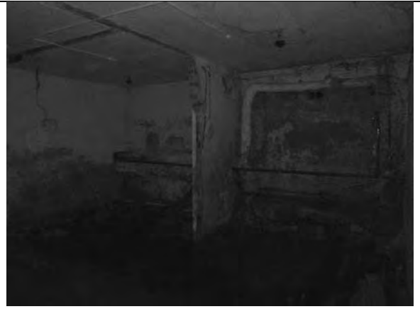
Фото 50. Состояние внутренних помещений.
