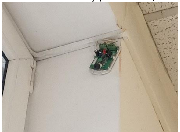
Фото 32. Состояние внутренних помещений.
