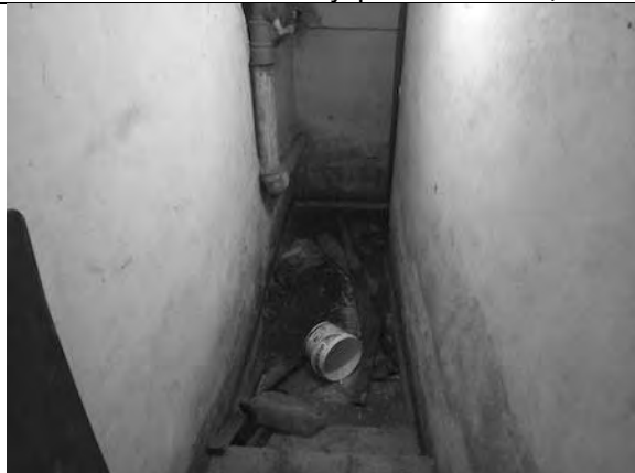
Фото 45. Состояние внутренних помещений.
