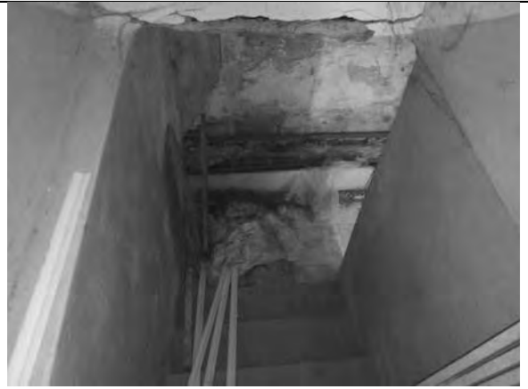
Фото 42. Состояние внутренних помещений.
