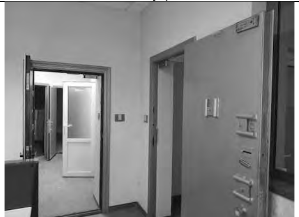
Фото 78. Состояние внутренних помещений.
