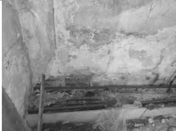
Фото 43. Состояние внутренних помещений.
