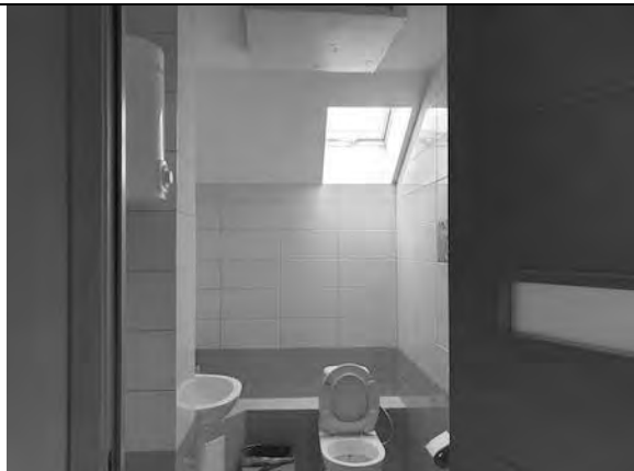
Фото 31. Этаж 3. Внутренние помещения объекта.
