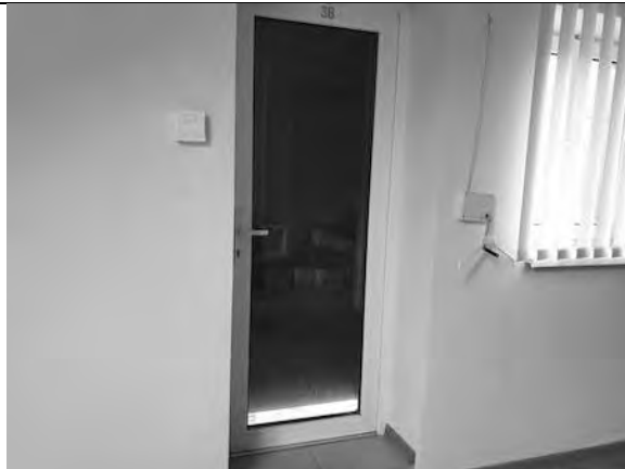
Фото 39. Этаж 3. Внутренние помещения объекта.
