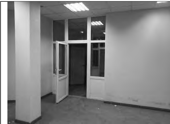
Фото 57. Состояние внутренних помещений.
