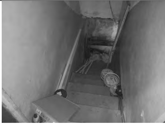
Фото 41. Состояние внутренних помещений.
