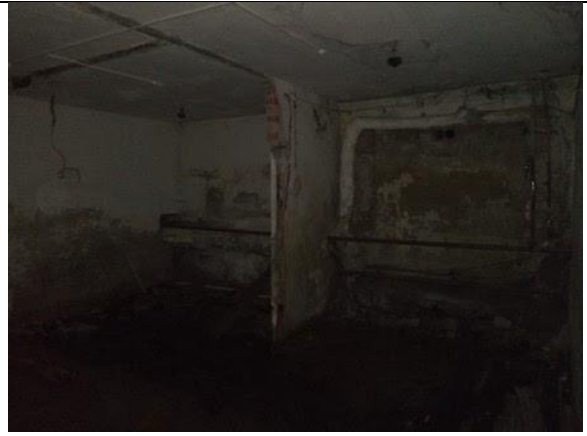
Фото 50. Состояние внутренних помещений.
