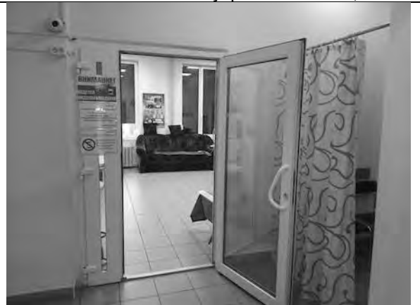
Фото 20. Состояние внутренних помещений.
