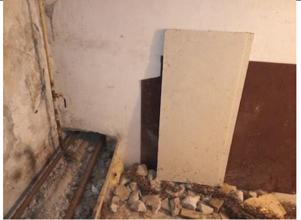
Фото 44. Состояние внутренних помещений.
