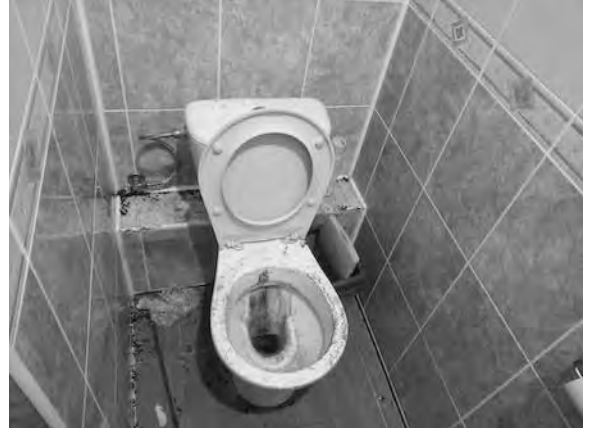
Фото 76. Состояние внутренних помещений.
