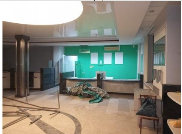
Фото 54. Состояние внутренних помещений.
