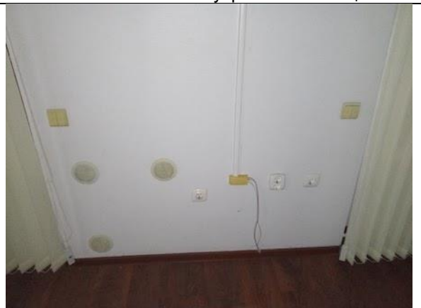
Фото 62. Состояние внутренних помещений.
