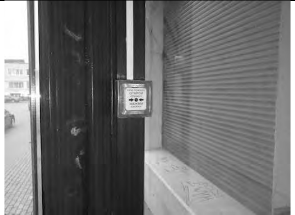
Фото 52. Состояние внутренних помещений.
