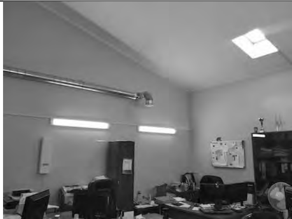
Фото 63. Этаж 5. Внутреннее помещение объекта.
