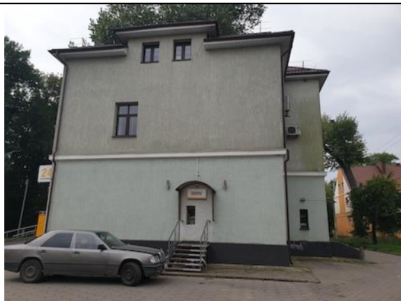
Фото 7. Внешнее состояние объекта
