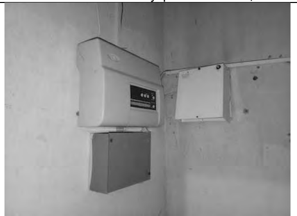
Фото 22. Состояние внутренних помещений.
