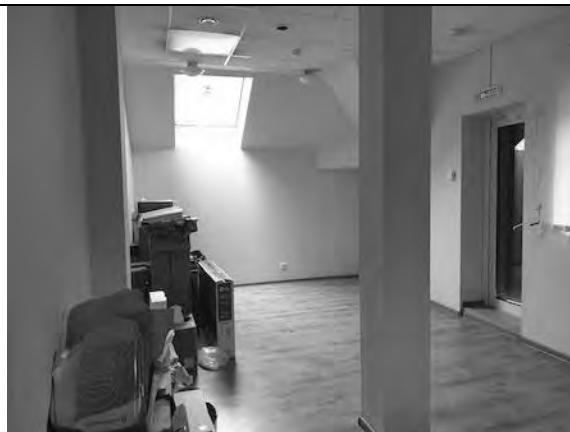
Фото 36. Этаж 3. Внутренние помещения объекта.
