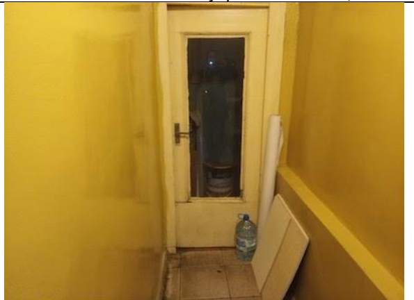
Фото 36. Состояние внутренних помещений.
