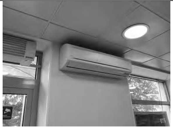
Фото 18. Этаж 1. Внутреннее помещение объекта.
