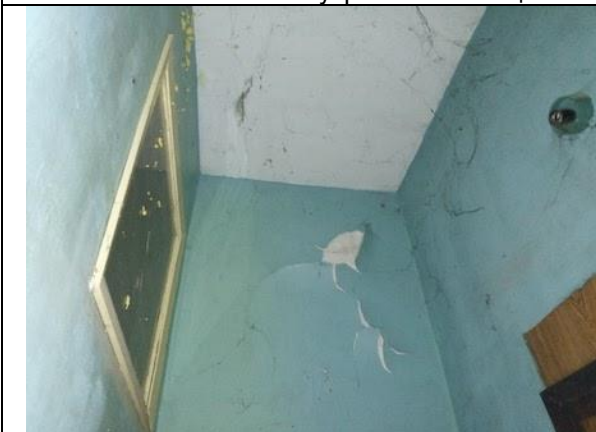
Фото 39. Состояние внутренних помещений.
