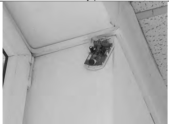
Фото 32. Состояние внутренних помещений.
