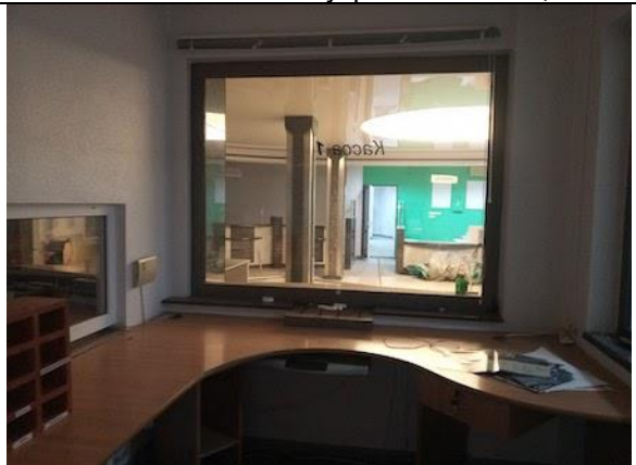
Фото 80. Состояние внутренних помещений.
