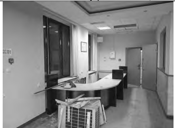
Фото 64. Состояние внутренних помещений.
