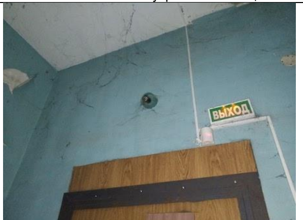
Фото 38. Состояние внутренних помещений.
