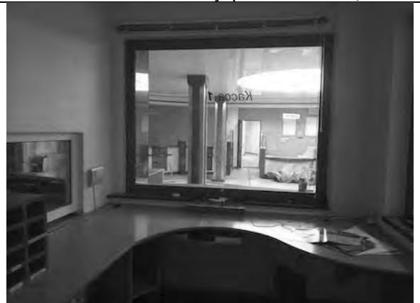
Фото 80. Состояние внутренних помещений.
