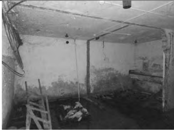
Фото 49. Состояние внутренних помещений.
