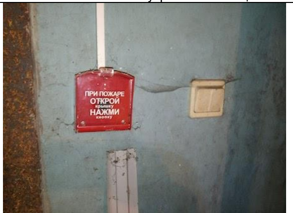
Фото 40. Состояние внутренних помещений.
