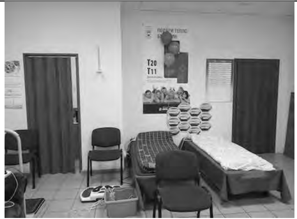
Фото 26. Состояние внутренних помещений.
