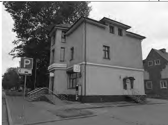
Фото 1. Внешнее состояние объекта.
