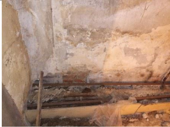
Фото 43. Состояние внутренних помещений.
