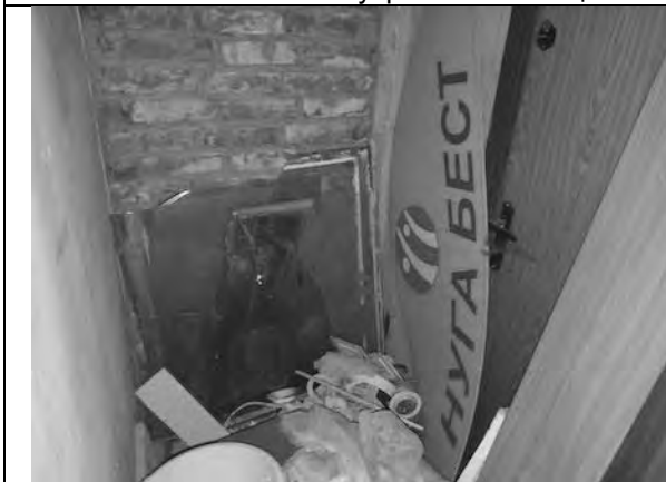
Фото 37. Состояние внутренних помещений.
