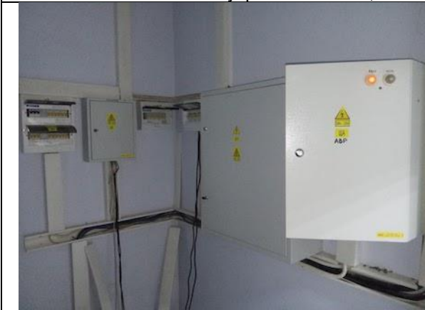
Фото 59. Состояние внутренних помещений.
