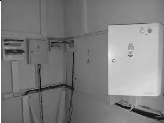
Фото 59. Состояние внутренних помещений.
