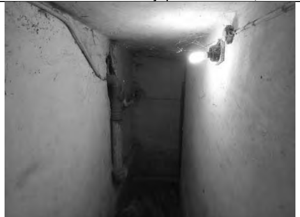
Фото 46. Состояние внутренних помещений.
