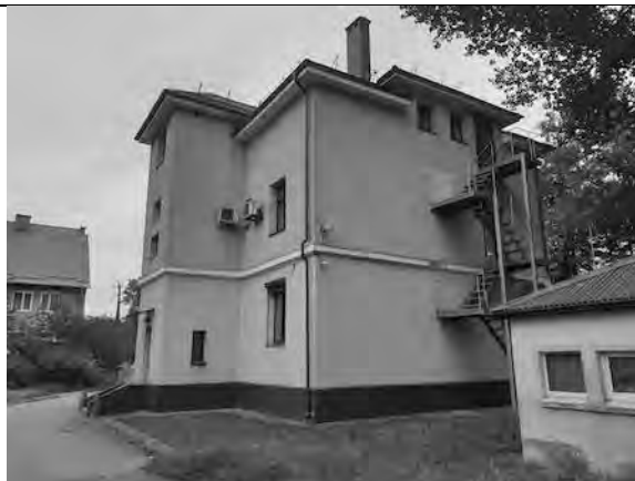
Фото 8. Внешнее состояние объекта
