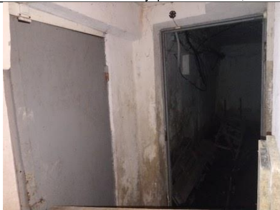
Фото 47. Состояние внутренних помещений.
