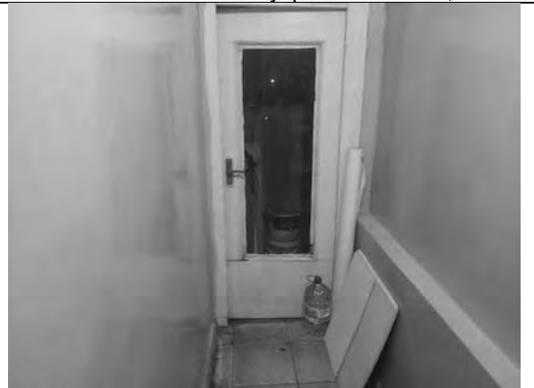
Фото 36. Состояние внутренних помещений.
