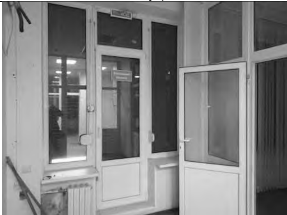
Фото 61. Состояние внутренних помещений.
