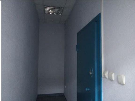
Фото 71. Состояние внутренних помещений.
