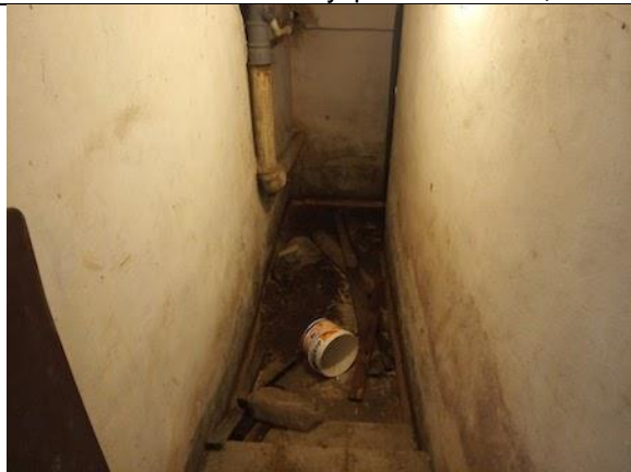
Фото 45. Состояние внутренних помещений.
