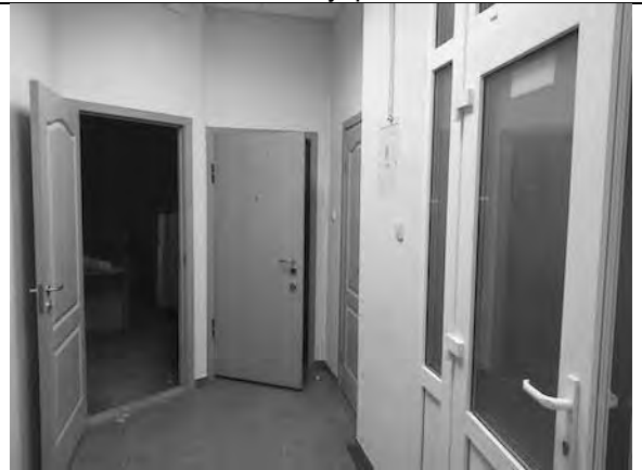
Фото 70. Состояние внутренних помещений.
