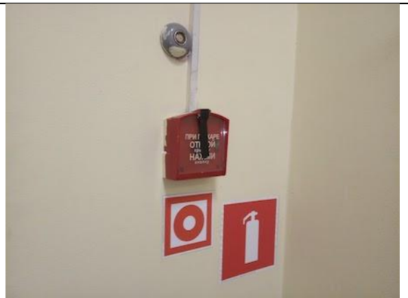
Фото 18. Состояние внутренних помещений.
