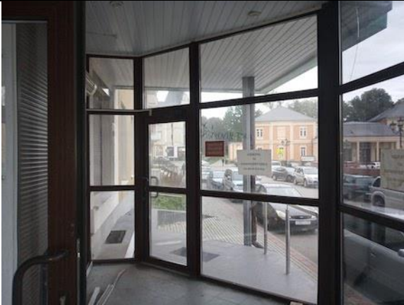
Фото 51. Состояние внутренних помещений.
