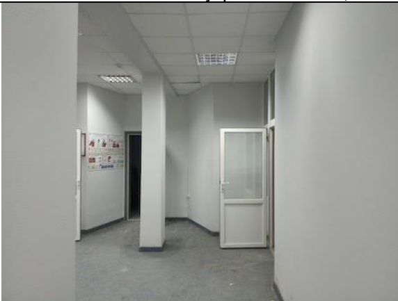
Фото 55. Состояние внутренних помещений.
