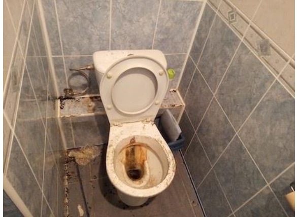
Фото 76. Состояние внутренних помещений.
