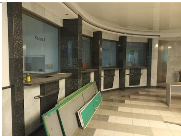
Фото 82. Состояние внутренних помещений.
