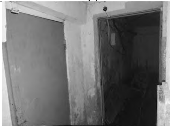
Фото 47. Состояние внутренних помещений.
