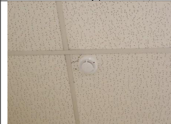
Фото 19. Состояние внутренних помещений.
