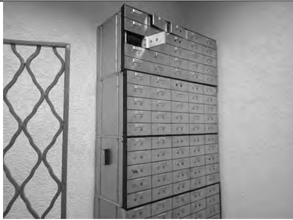
Фото 73. Состояние внутренних помещений.
