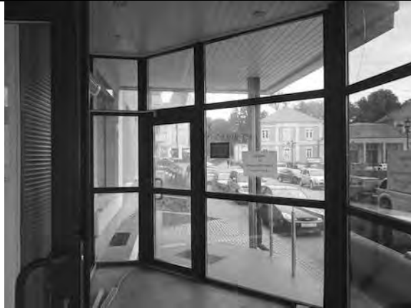
Фото 51. Состояние внутренних помещений.
