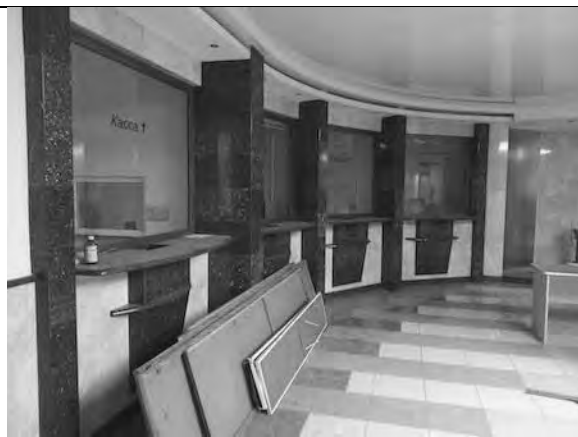
Фото 82. Состояние внутренних помещений.
