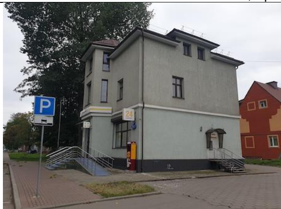
Фото 1. Внешнее состояние объекта.
