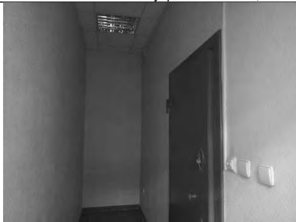
Фото 71. Состояние внутренних помещений.
