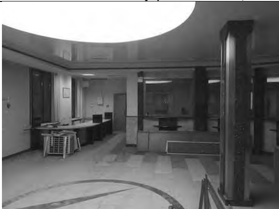
Фото 63. Состояние внутренних помещений.
